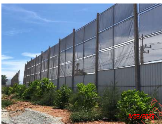
แนวกำแพงป้องกันผลกระทบด้านฝุ่นละอองบริเวณด้านหน้าโครงการ
