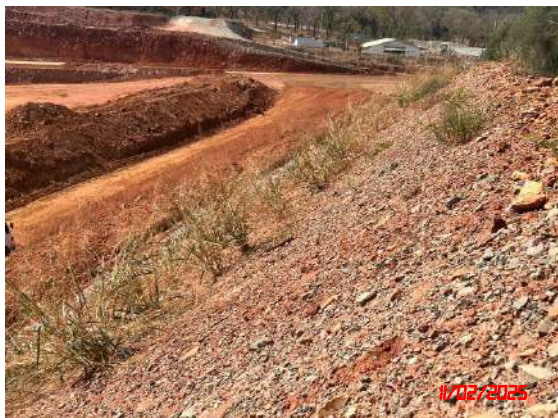
การปลูกหญ้าชนิดอู๋ดินบนพื้นที่ลาดชัน
